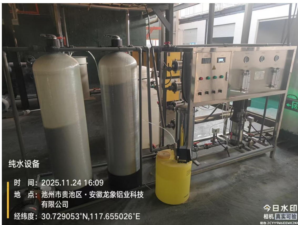
图 3.4.2 纯水制备设备照片
