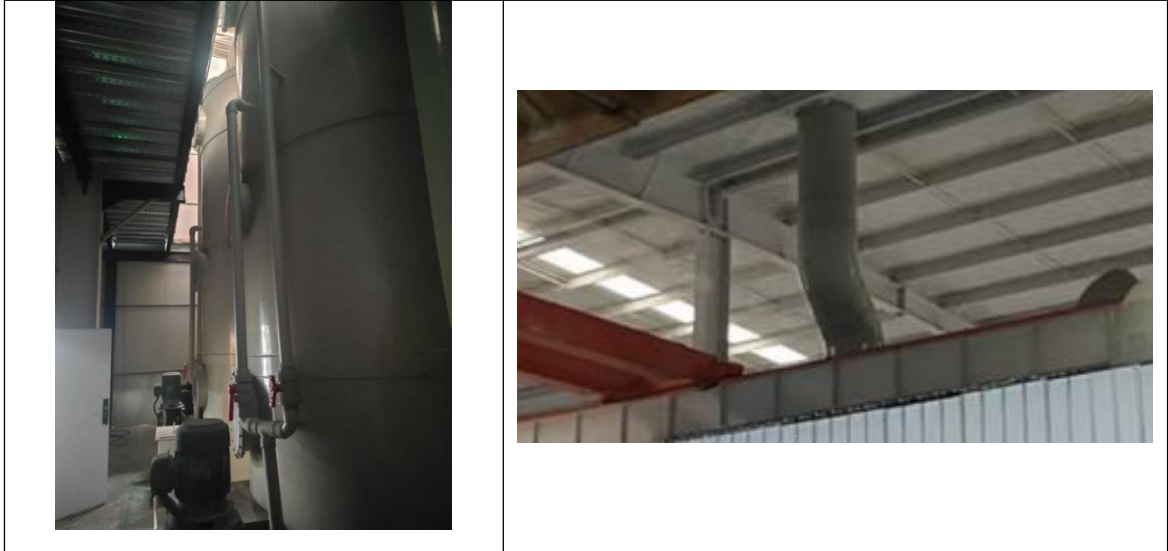
废气处理装置（水喷淋塔）和排放口（DA002）
