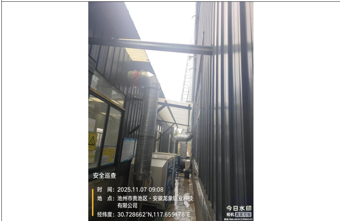
废气处理装置（二级活性炭吸附装置）和排放口（DA008）
