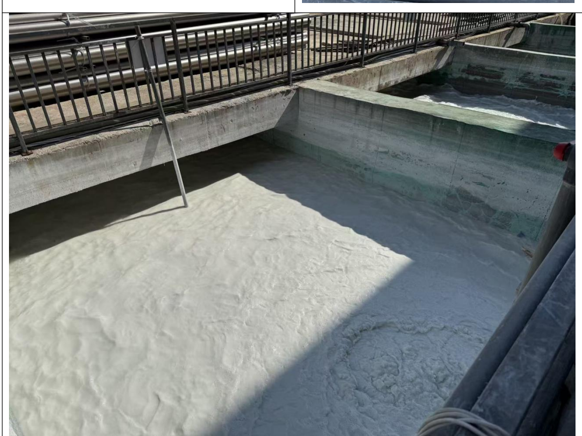
脱脂废水处理设施 (pH调节+气浮+混凝沉淀)
