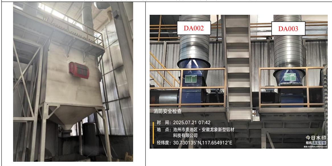
废气处理装置（旋风式分离器+滤芯回收装置）和排放口（DA005）
