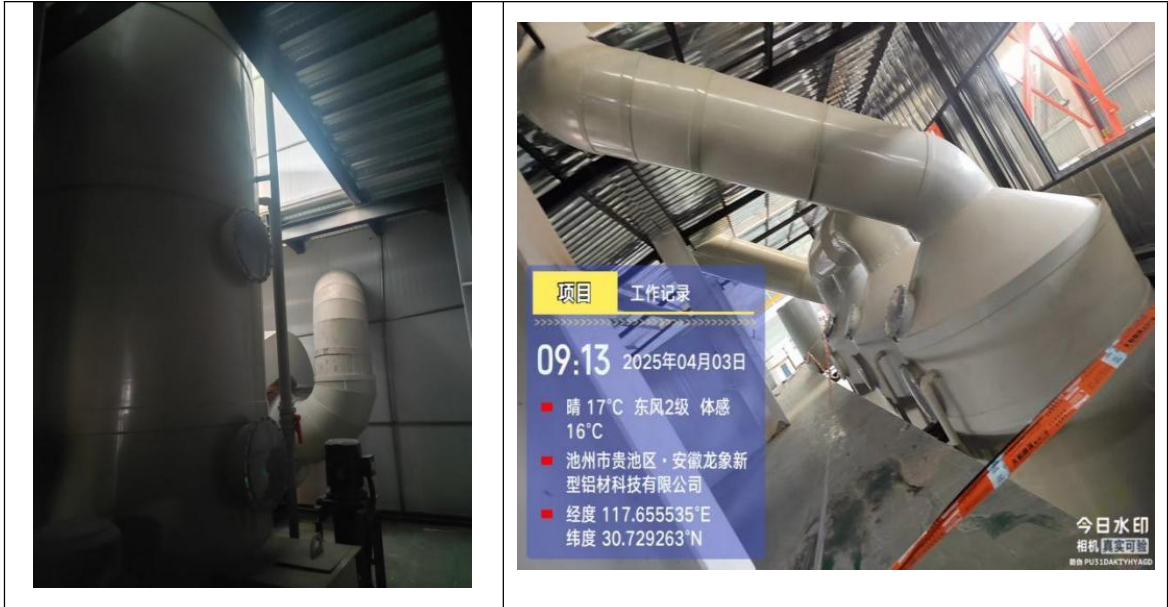
废气处理装置（碱液喷淋塔）和排放口（DA001）
