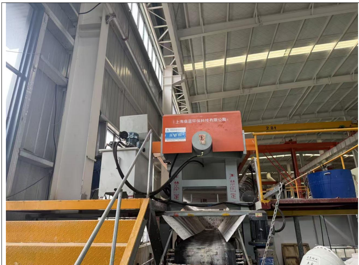
综合废水处理设施（pH调节+絮凝沉淀、压滤机）
