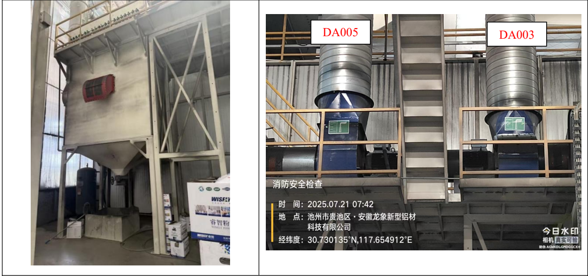
废气处理装置（旋风式分离器+滤芯回收装置）和排放口（DA003）
